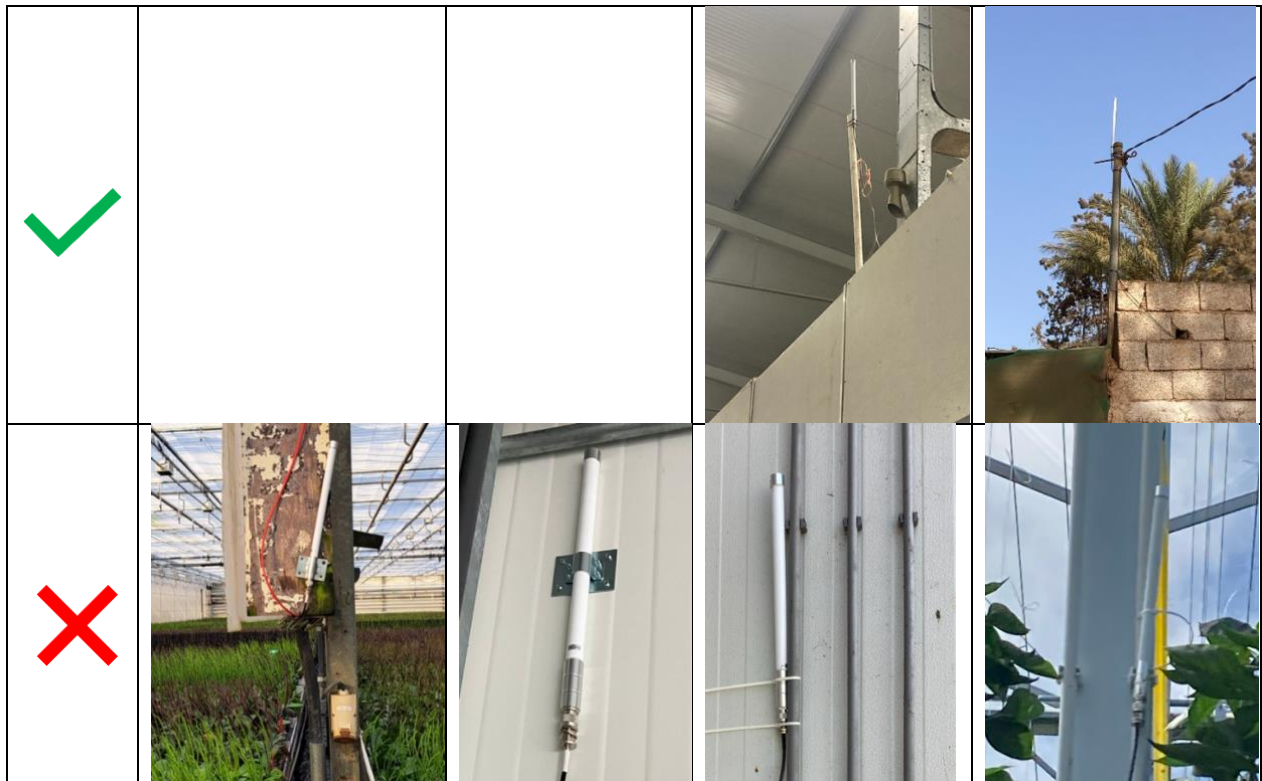
Figuur 4: Goede en verkeerde bevestiging van de antenne
